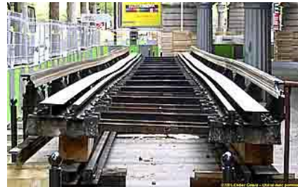
Componentes de la vía
